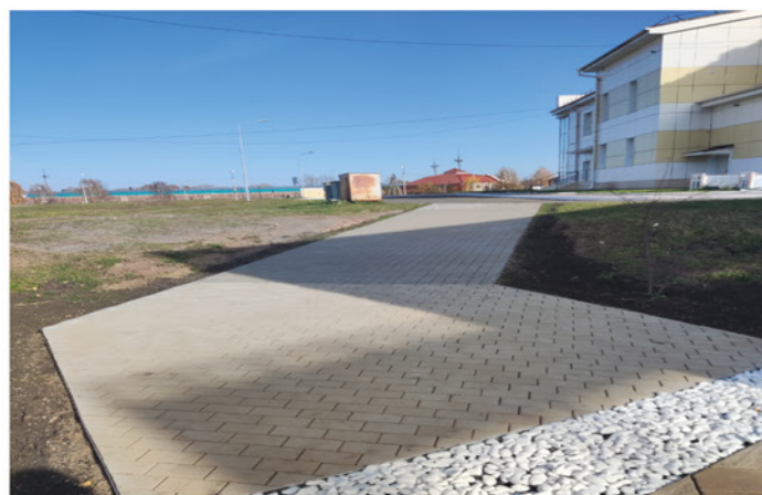
Устроены разные виды покрытий: мраморная крошка, брусчатое покрытие (зеленая и степняк)
